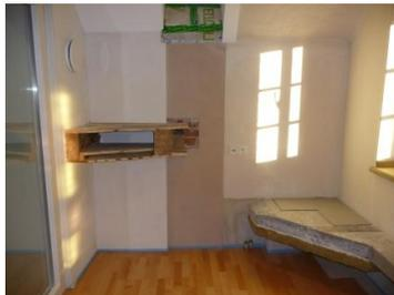
**Geschossdecken durchbrechen die Innendämmung.**
