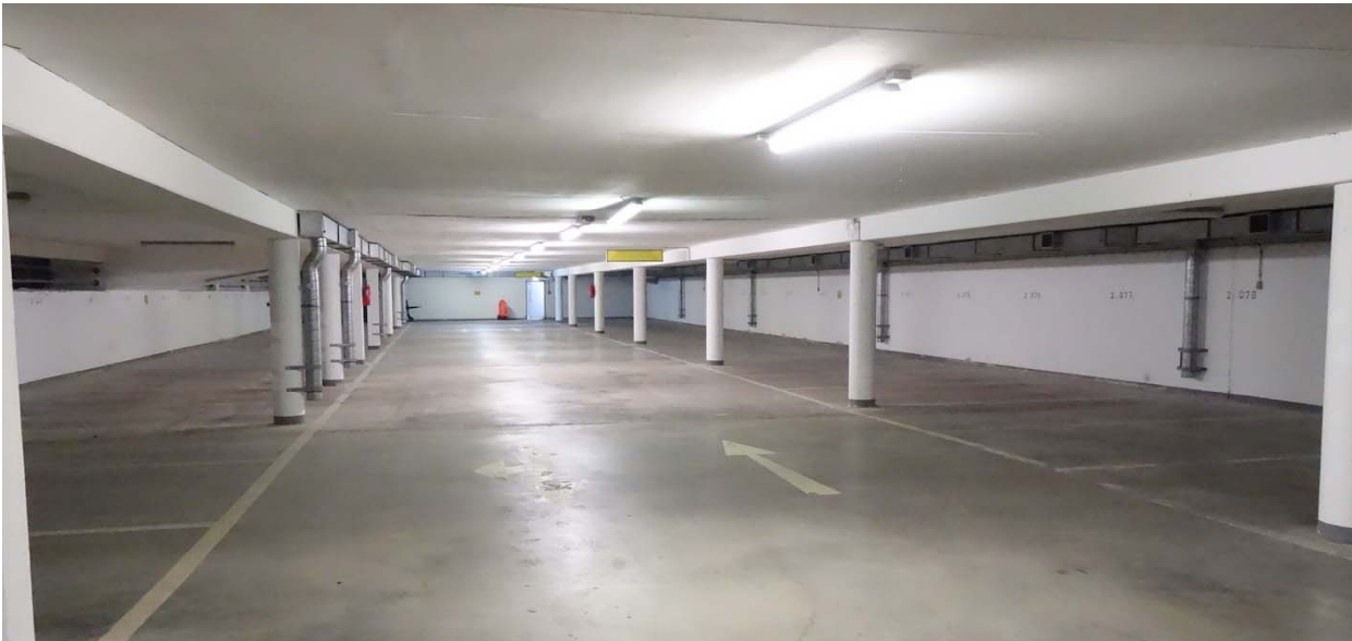
Blick in die Tiefgarage zum Zeitpunkt der Vorbeprobung
